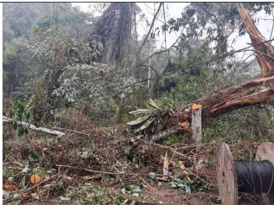
**FOTO 03:** Árvores caídas em meio a rede de distribuição de energia elétrica o que comprometeu a distribuição de energia no interior as margens da estrada, este cenário se repete em vários locais.
